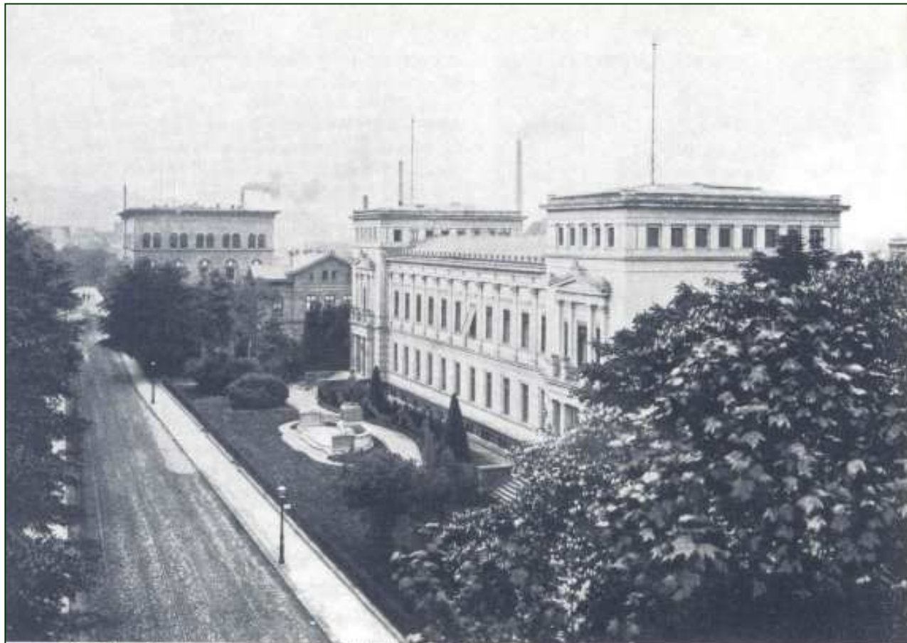
26. Altes Chemisches Institut, Gebäudefront zur Meckenheimer Allee. Zustand um 1904.
